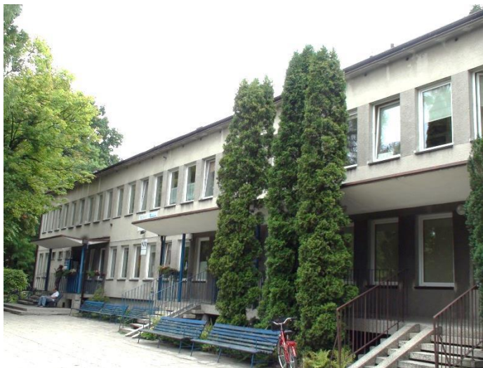
Rys.60 Przychodnia. Przykładowa fotografia budynku.
