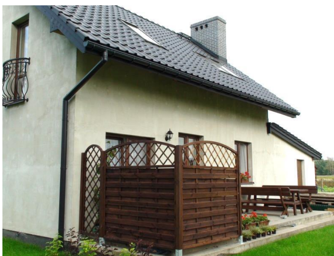
Rys 53. Dom jednorodzinny. Przykładowa fotografia budynku.
