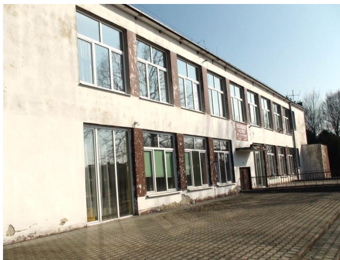
Rys.58 Budynek użyteczności publicznej – przedszkole. Przykładowa fotografia budynku
